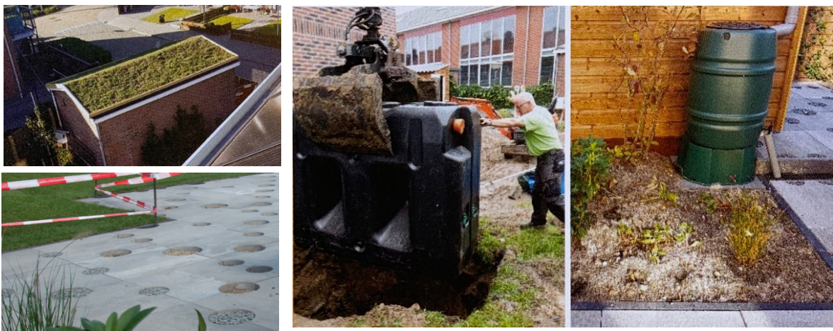
Figuur 10.6: De ideale Watertuin met een groen dak, waterdoorlatende verharding, ondergrondse watertank en een regenton aan de Tasmanweg te Hoek van Holland (Buro Bergh, 2018; Klimaatkrachtig Delfland, z.d.-a).
