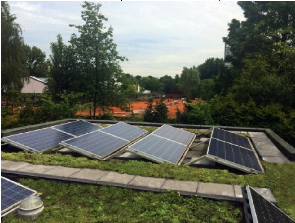
Figuur 10.3: Groen dak in combinatie met zonnepanelen op de Amstelveenseweg te Amsterdam (Moss Amsterdam, 2016)
