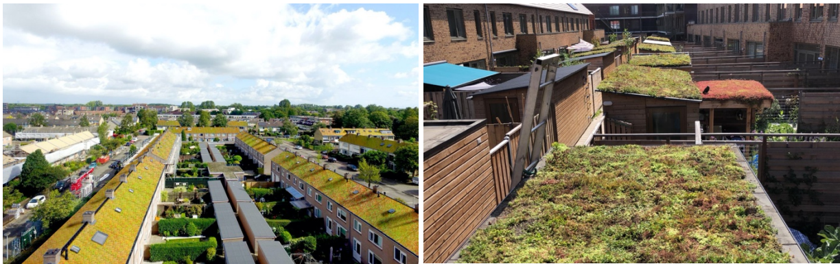
Figuur 9.9: Links sedum op daken van rijtjeswoningen (Teekens, z.d.) en rechts sedum op de daken van de schuurtjes in de Kleine Wijk in Utrecht (Bewonersvereniging Het Kleine Wijk, 2019)
