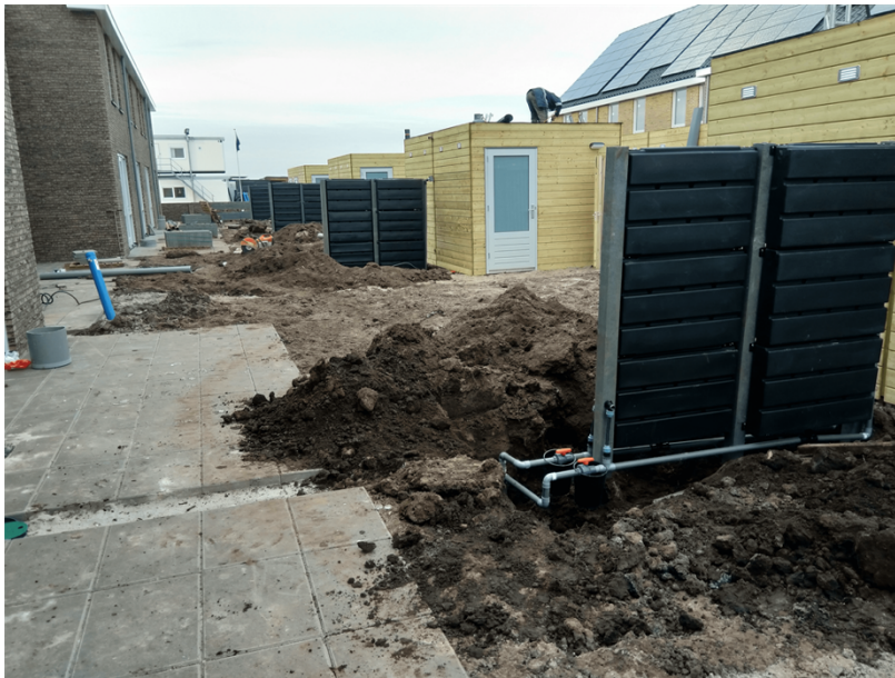
Figuur 10.5: Aanleg van de modulaire Regenwaterschutting 'Rainwinner' in Breecamp Noord (Zwolle) (Kennisportaal Ruimtelijke Adaptatie, 2019)
