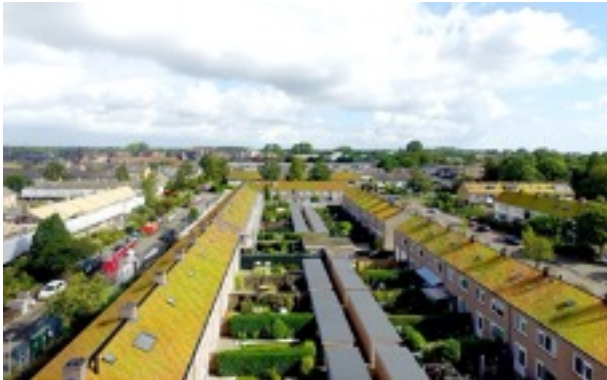
Figuur 10.17: Groene dakpan op de eengezinswoningen in de wijk Transburg in Enschede (Teekens, z.d.)
