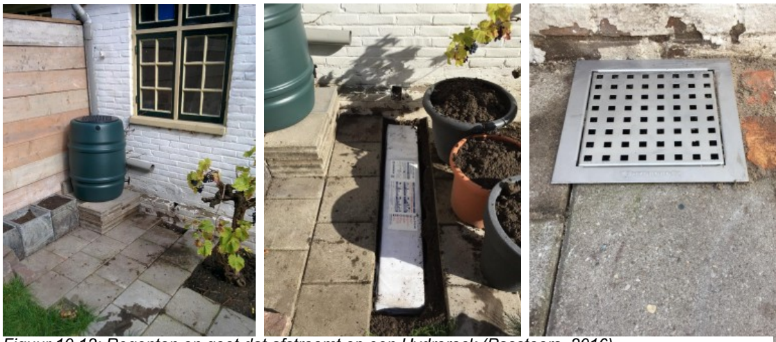
Figuur 10.12: Regenton en goot dat afstroomt op een Hydrorock (Passtoors, 2016)
