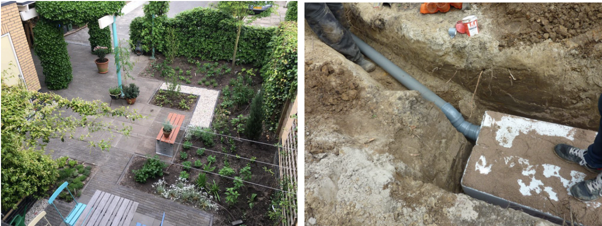
Figuur 10.13: Klimaatbestendige tuin en de regenwaterafvoer gekoppeld aan de ingegraven infiltratieblokken (Lekker in je tuin, z.d.)
