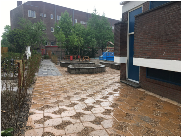
Figuur 9.11: Rain(a)way-tegels in een klimaatbestendige binnentuin bij de Matheneserflat in Rotterdam (Rain(a)way, 2019)
