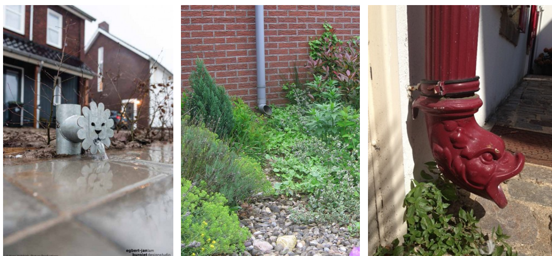
Figuur 9.1: Links waterspuwer (BuroJET, z.d.). Midden Afkoppelen regenwater (Hdsr, z.d.). Rechts afkoppelen op een ludieke manier (Amsterdam Rainproof, 2020-a).
