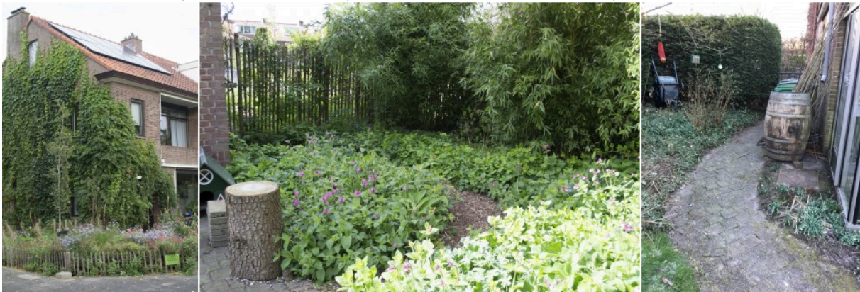
Figuur 10.14: Groene gevel, waterdoorlatende verharding en een regenton in Amstelveen (Amstelveen Rainproof, 2018)
