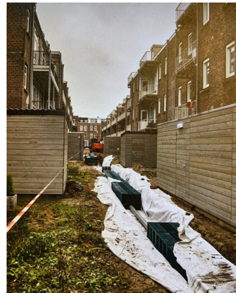
Figuur 5.5: Gemeenschappelijke binnenterrein van de huurwoningen aan de Schans-Watergeusblok te Rotterdam (Buro Bergh, 2019).
