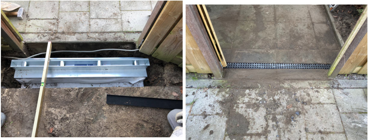
Figuur 10.1: Infiltrerende lijngoot in tuin Buitenveldert (Van Veen, 2020; RWBNL, z.d.-a)
